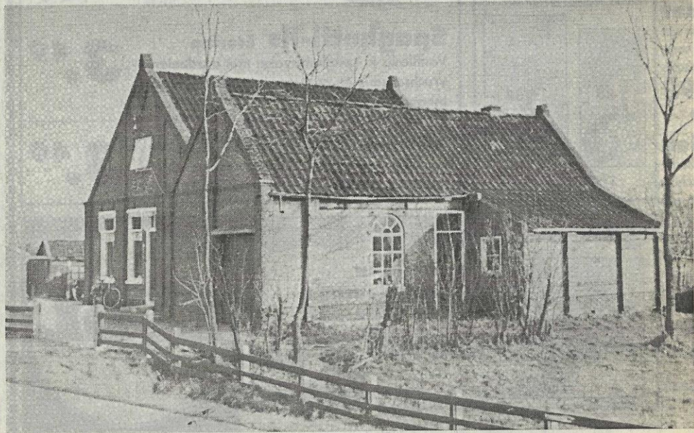
Opname van het voormalige 'koekjefebryk' genomen voor de verbouwing in 1966. Het westelijke deel (op de foto rechts) werd toen afgebroken. (Foto: A. van Lune)
